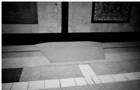
Рис. 7.32. Насадной стационарный пандус для заезда в вагон на инвалидной коляске. Метро г. Казань
