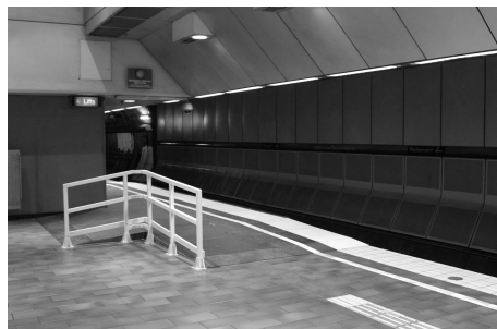
Рис. 7.33. Дополнительная платформа-пандус для подъема инвалидов на коляске станция Парламент г. Мельбурн центральная платформа 3
